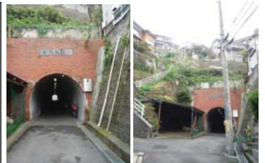
⑳ 向坂トンネル 67m 昭和 8 年
