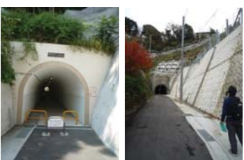
⑱ 平六トンネル 90m 昭和 14 年
