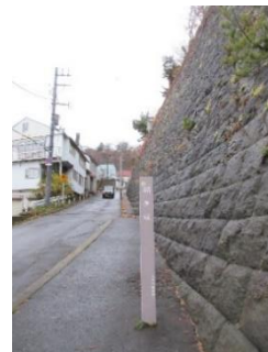
坂下にも坂標がある
